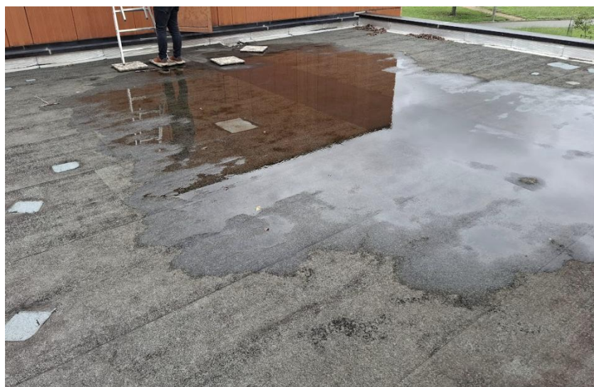
Beaucoup d'impact de grêle (carré vert) Réparations faites pour éviter les infiltrations en urgence
