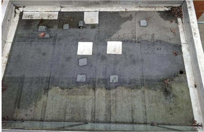
Beaucoup d'impact de grêle (carré vert – patch chape bitume) Réparations faites pour éviter les infiltrations en urgence Relevé et habillage des acrotères à reprendre car de nombreuses faiblesses
