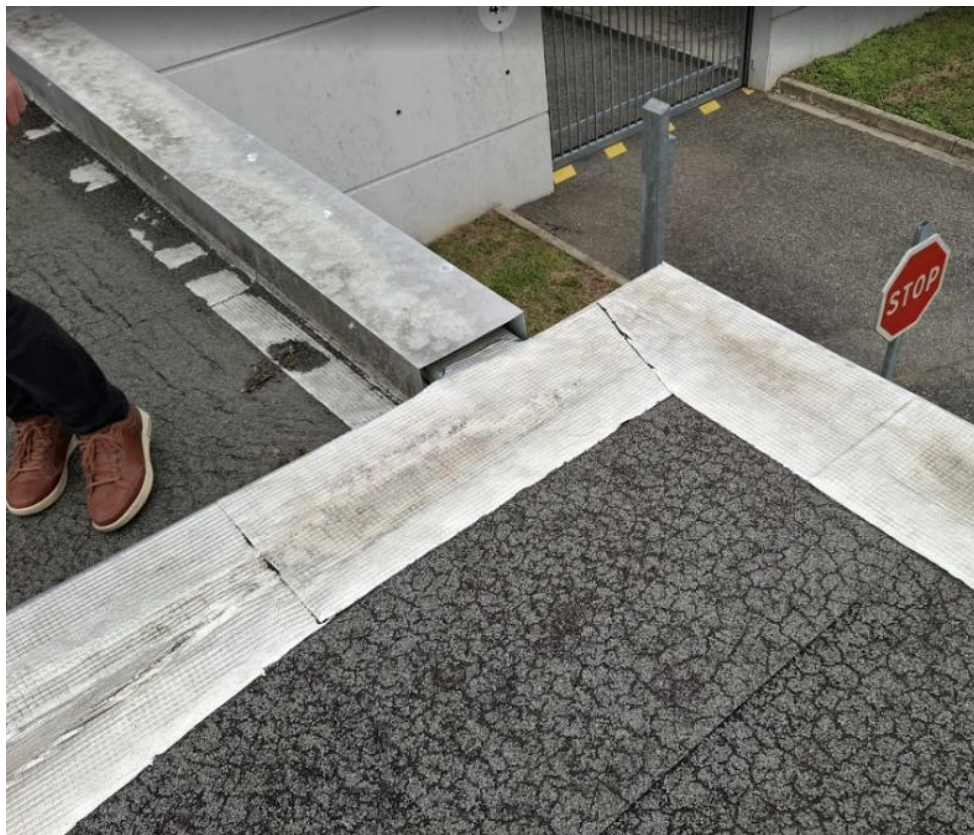
Etanchéité faîencée
