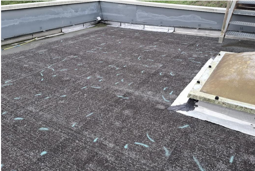
Impact de grêle sur étanchéité (marque en vert)
