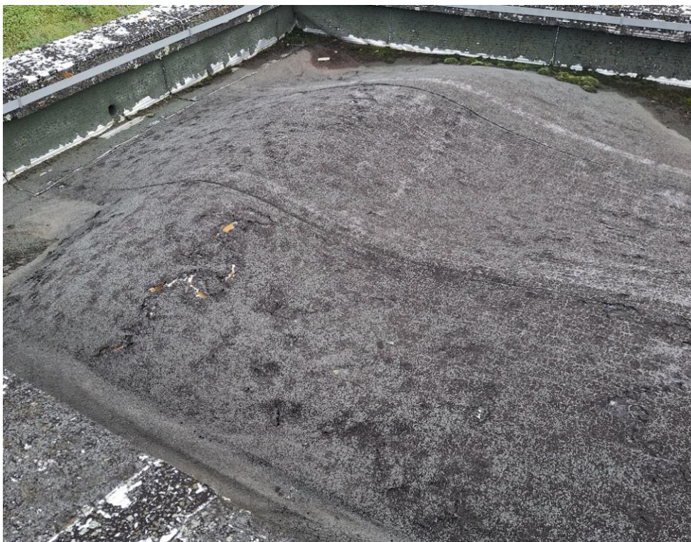
Sur la terrasse de droite, le complexe a « tuilé ». L'isolant PU s'est déformé au contact de l'eau, du à une infiltration
