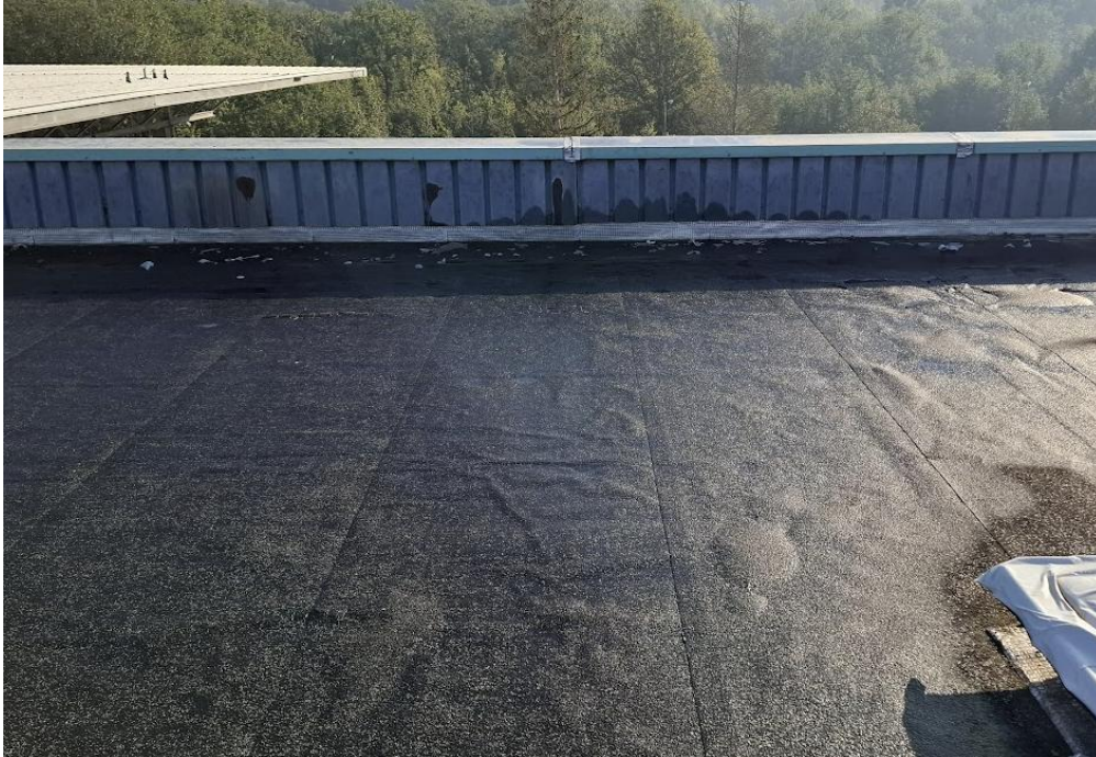
Bardage acier sur acrotère corrodé / Couvertine vieillissante
