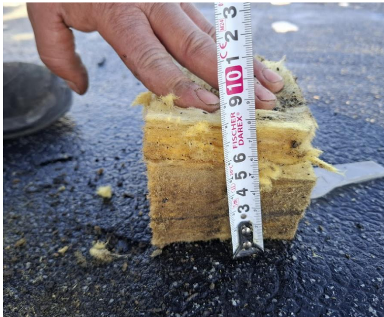
Le sondage met en évidence un rechapage.
