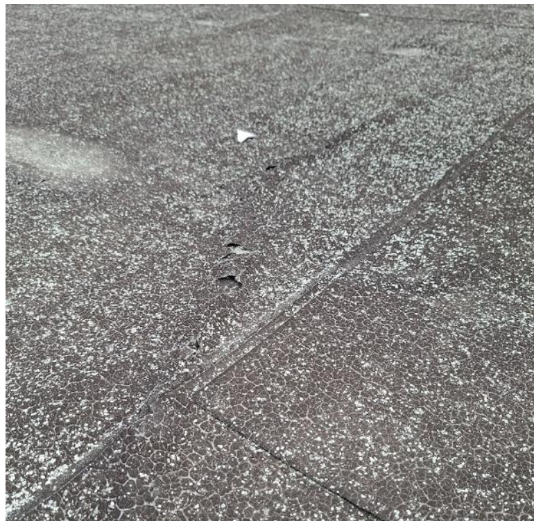
Impact de grêle sur étanchéité, trous visibles source d'infiltration
