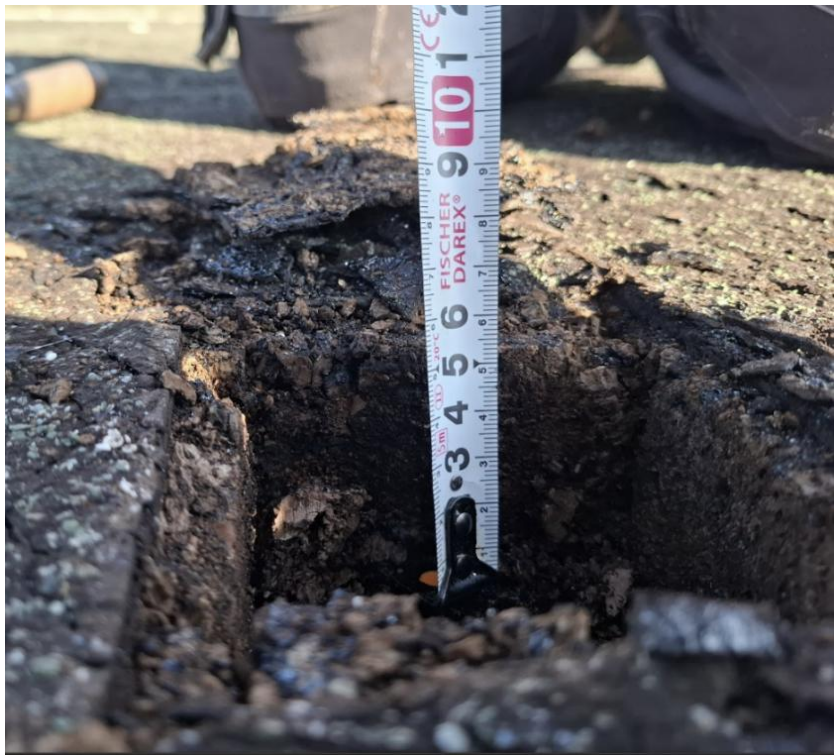
Le sondage met en évidence un monocouche sur un isolant en liège, à remplacer Celui-ci à une épaisseur de 50 mm sur un support béton.
