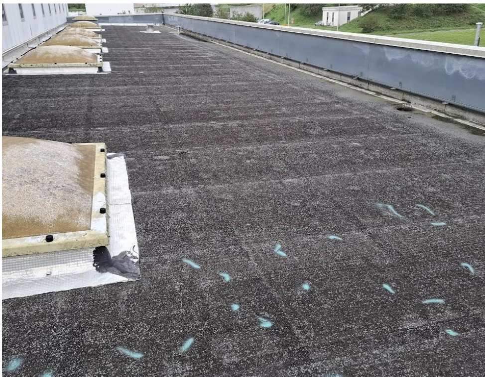
Impact de grêle sur étanchéité (marque en vert)
