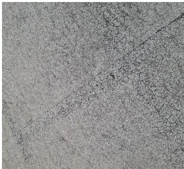
Couvertines vieillissantes / Etanchéité faïencée avec impact de grêle
