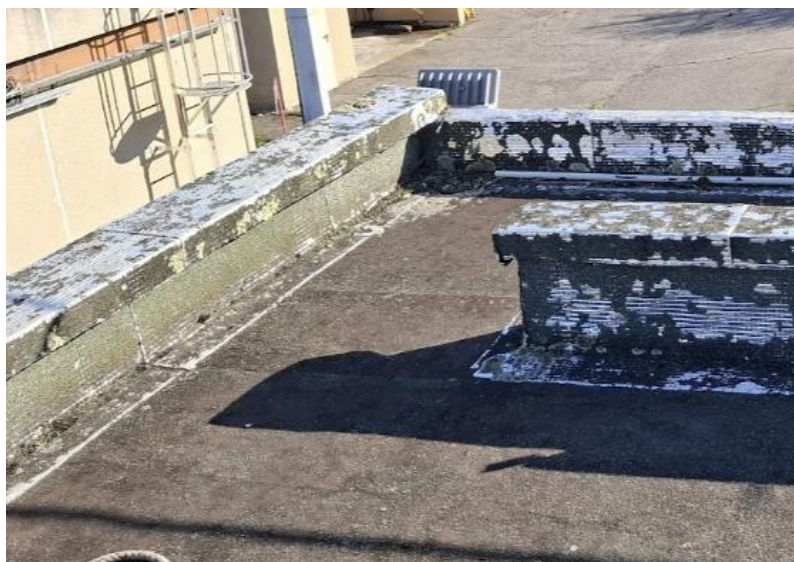
Etat général très vieillissant / étanchéité faïencée / Impact de grêle
