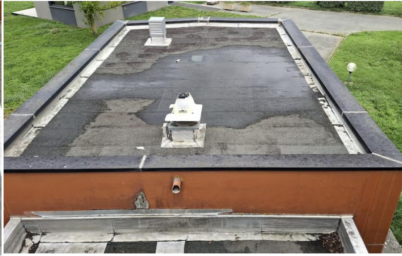
Beaucoup d'impact de grêle (carré vert – patch chape bitume) Réparations faites pour éviter les infiltrations en urgence Relevé et habillage des acrotères à reprendre car de nombreuses faiblesses
