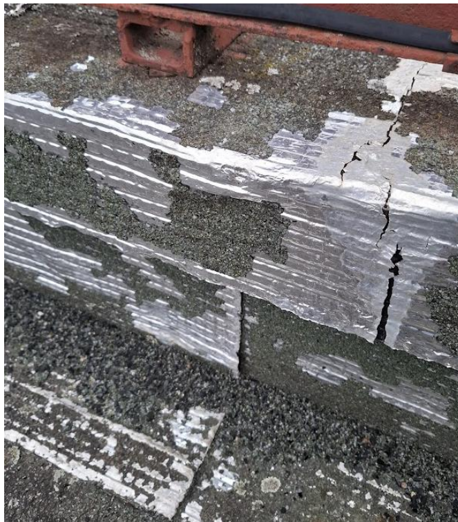
Le bitume sur les relevés est complètement désagrégré
