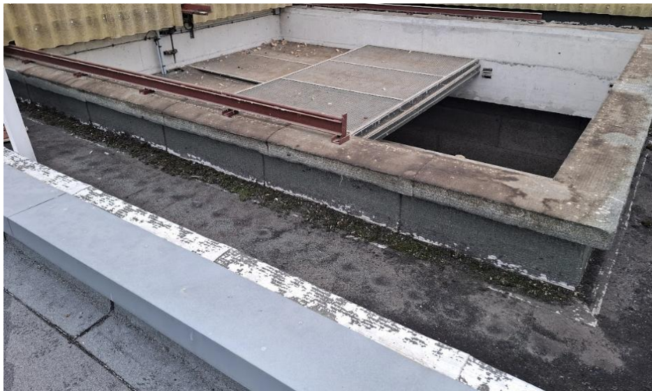
Membrane étanchéité bitume alu gaufré délité. Feuilles alu craquelées
