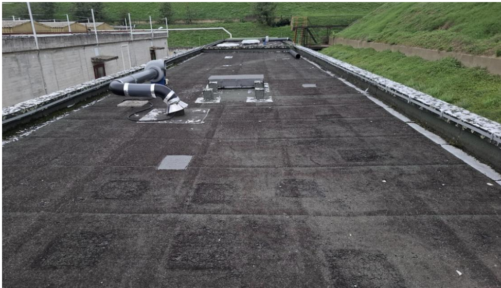
Etat général vieillissant / étanchéité faïencée
