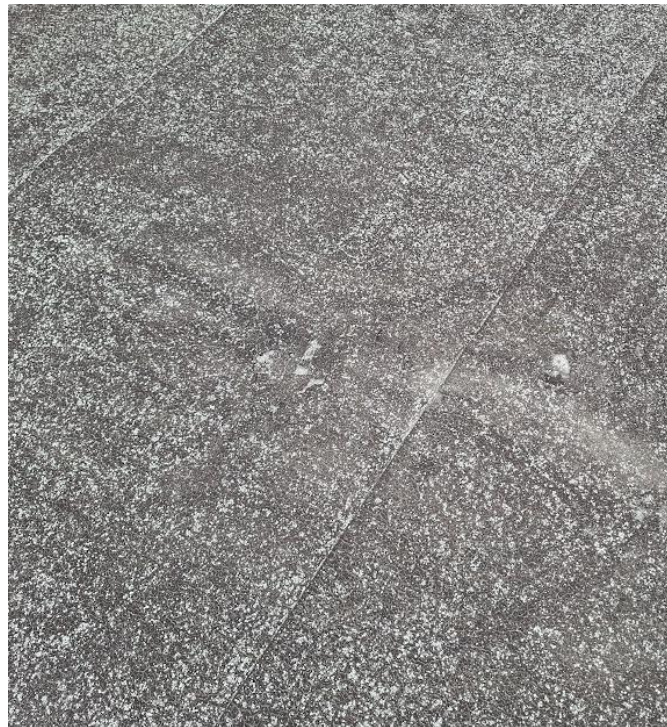
Impact de grêle sur étanchéité
