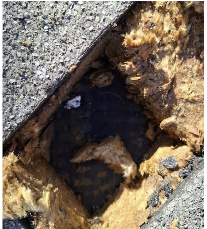
Le sondage R+2 met en évidence eun complexe bicouche sur isolant de laine minérale. L'isolant est trempé et mesure 60 mm d'épaisseur
