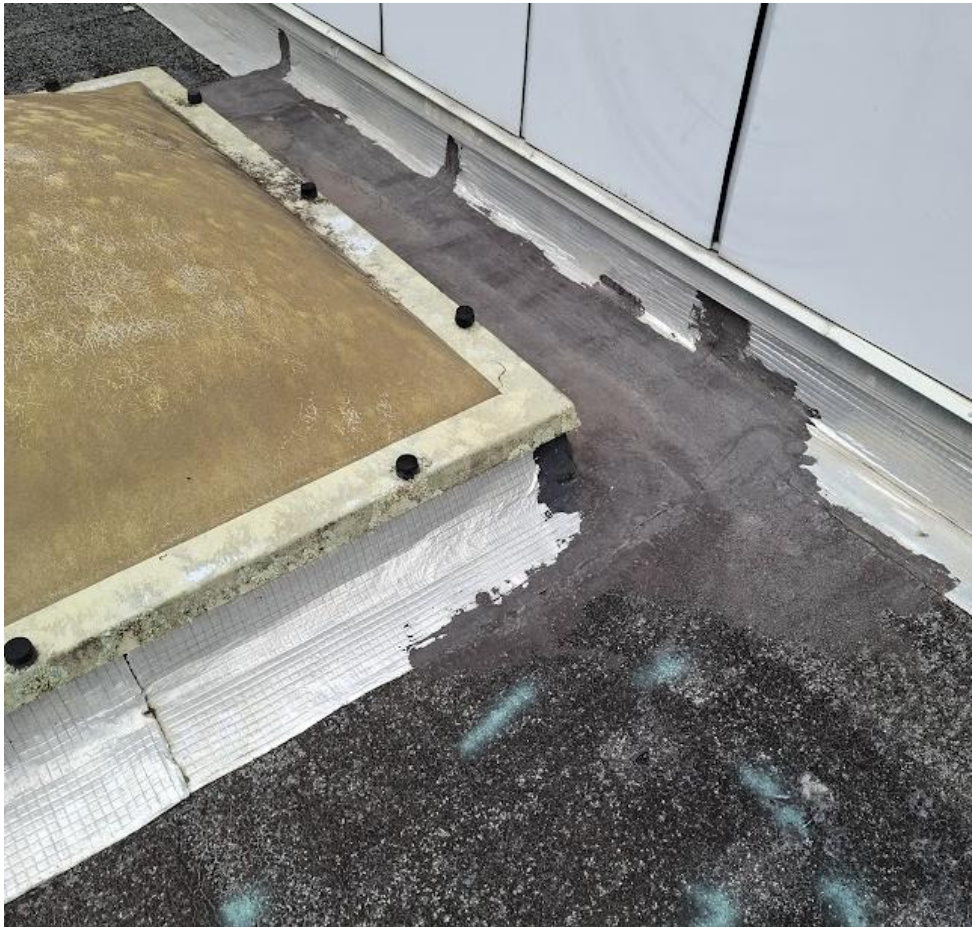
Des reprises sur relevé ont été réalisées avec un flashing
