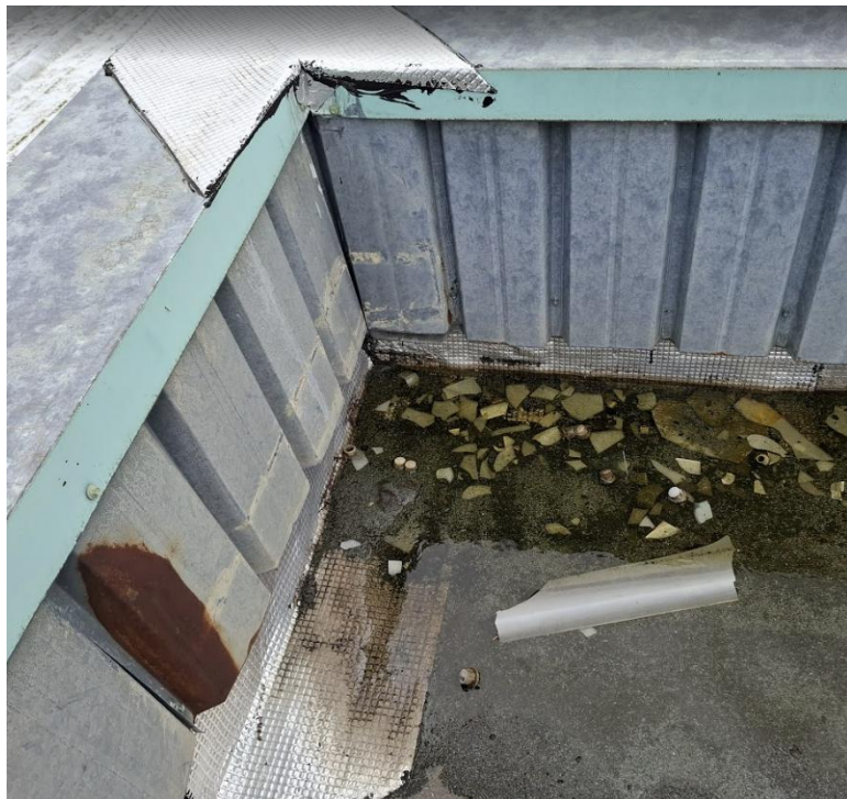
Bardage acier sur acrotère corrodé
