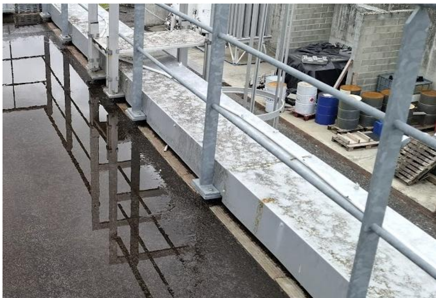
Couvertines vieillissantes / Etanchéité faïencée avec impact de grêle
