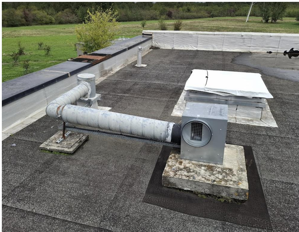
Couvertines vieillissantes
