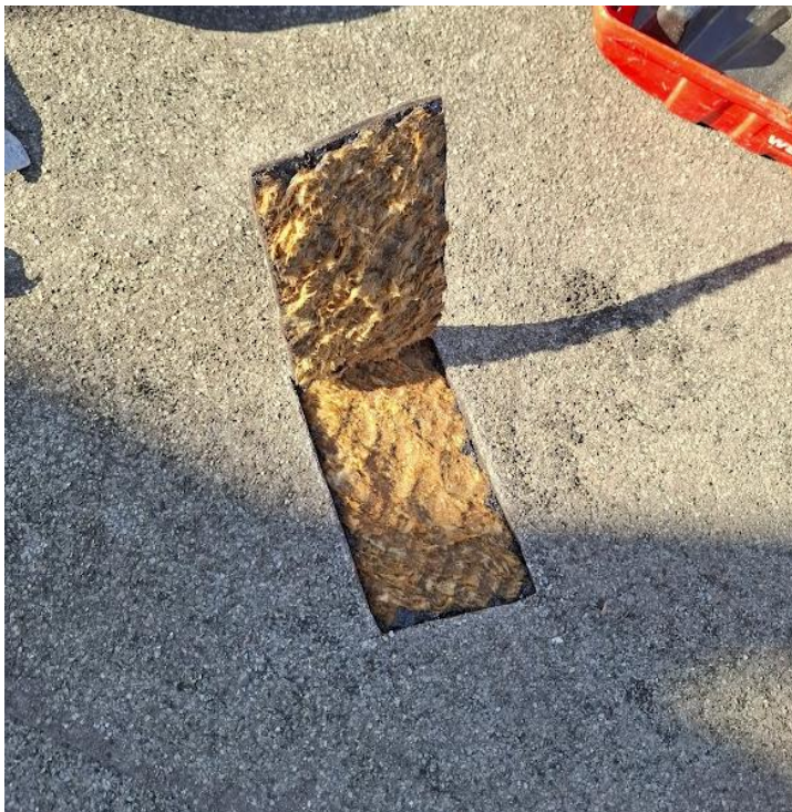
Le sondage R+2 met en évidence eun complexe bicouche sur isolant de laine minérale. L'isolant est trempé et mesure 60 mm d'épaisseur
