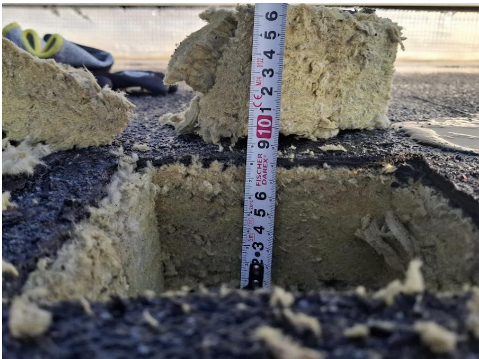
Le sondage met en évidence un complexe bicouche non rechapé avec un isolant en laine de roche sur bac acier. L'isolant est en bon état, sec sur 80 mm d'épaisseur.
