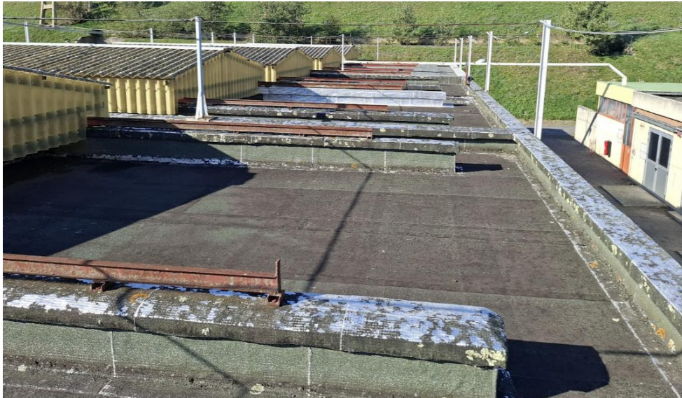
Etat général très vieillissant / étanchéité faïencée
