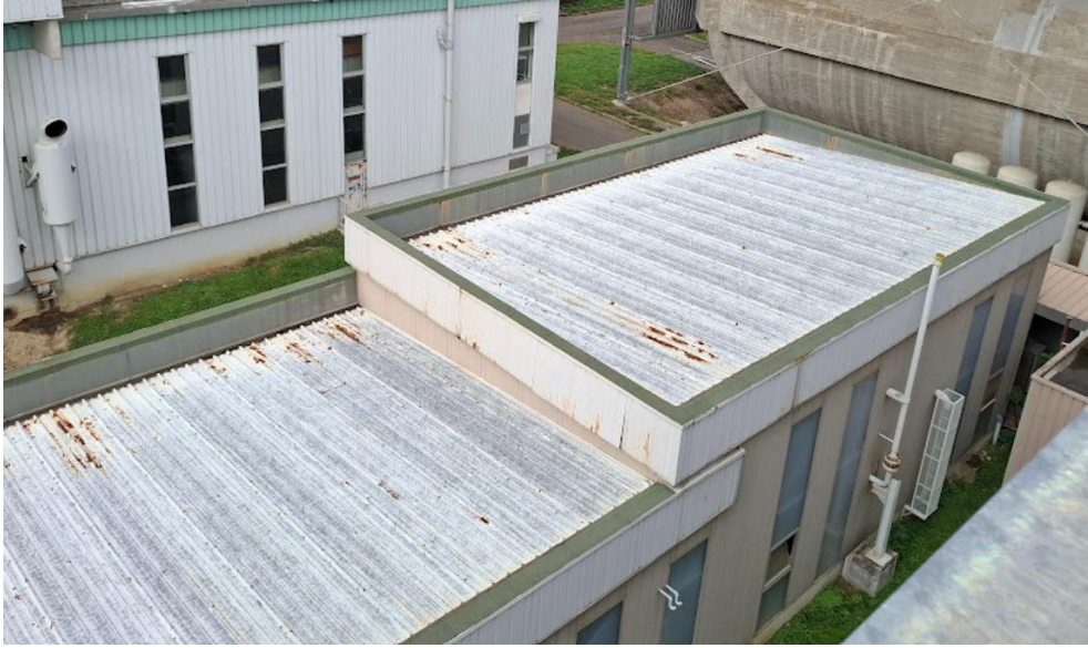
Etat général des bacs de couverture vieillissant – corrosion notable
