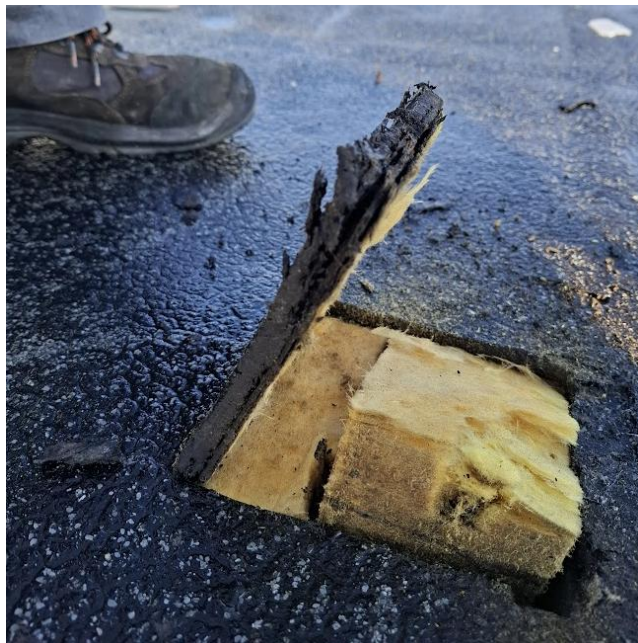
L'isolant en laine minérale est en bon état sur 80 mm d'épaisseur.
