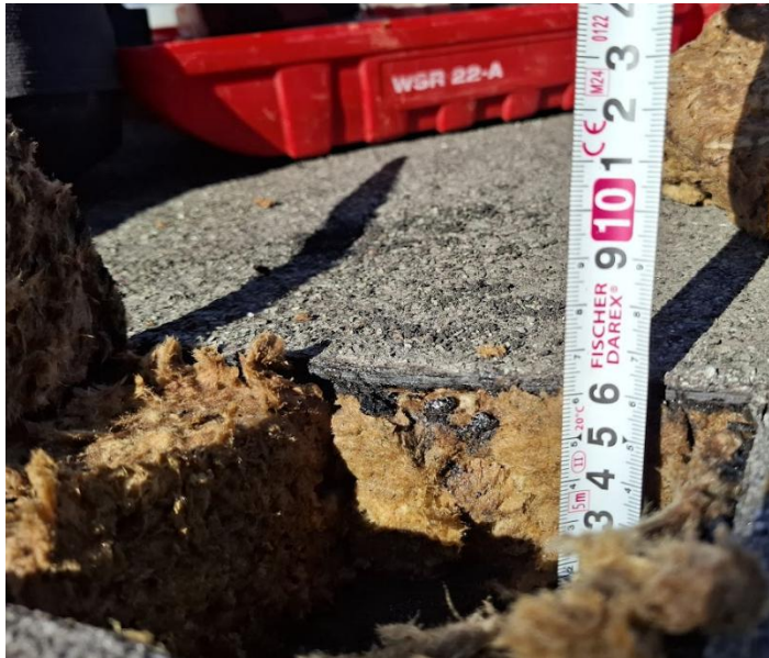
Le sondage R+ 3 met en évidence un complexe bicouche sur isolant de laine minérale. L'isolant est trempé et mesure 60 mm d'épaisseur
