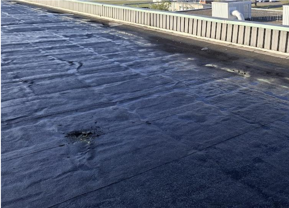
Impact de grêle sur étanchéité, feuille complètement désagrégée
