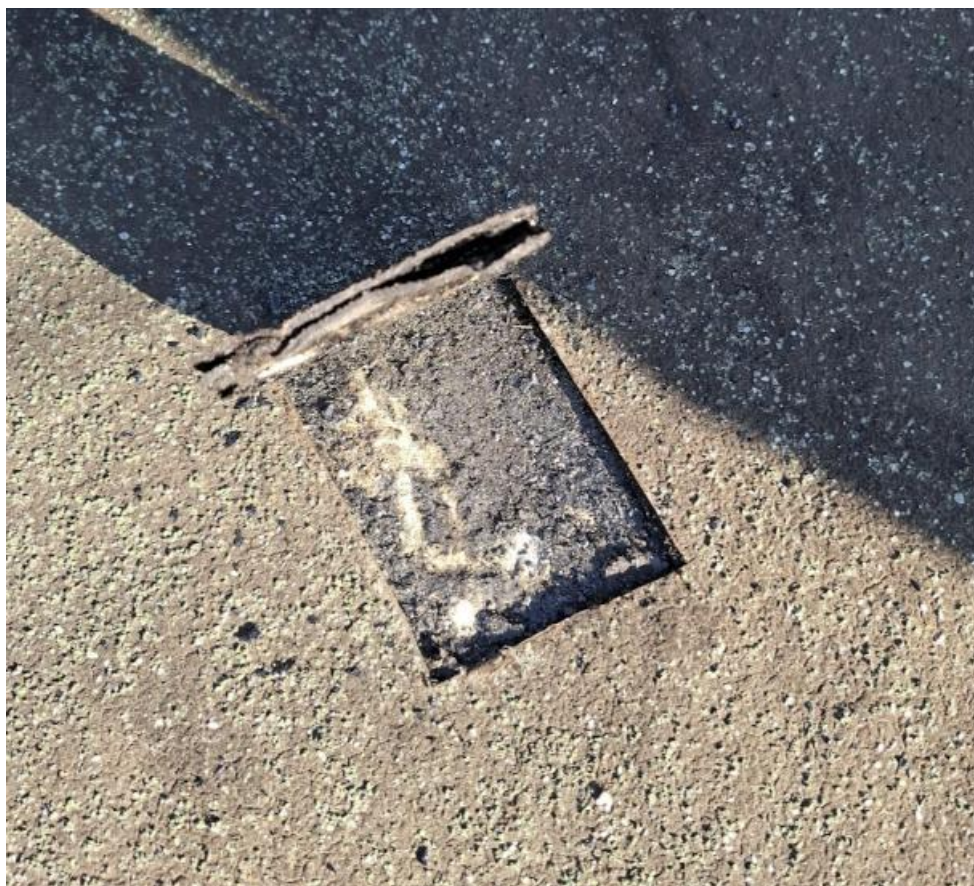
Le sondage met en évidence un bitume sur EIF directement sur dalle béton.
