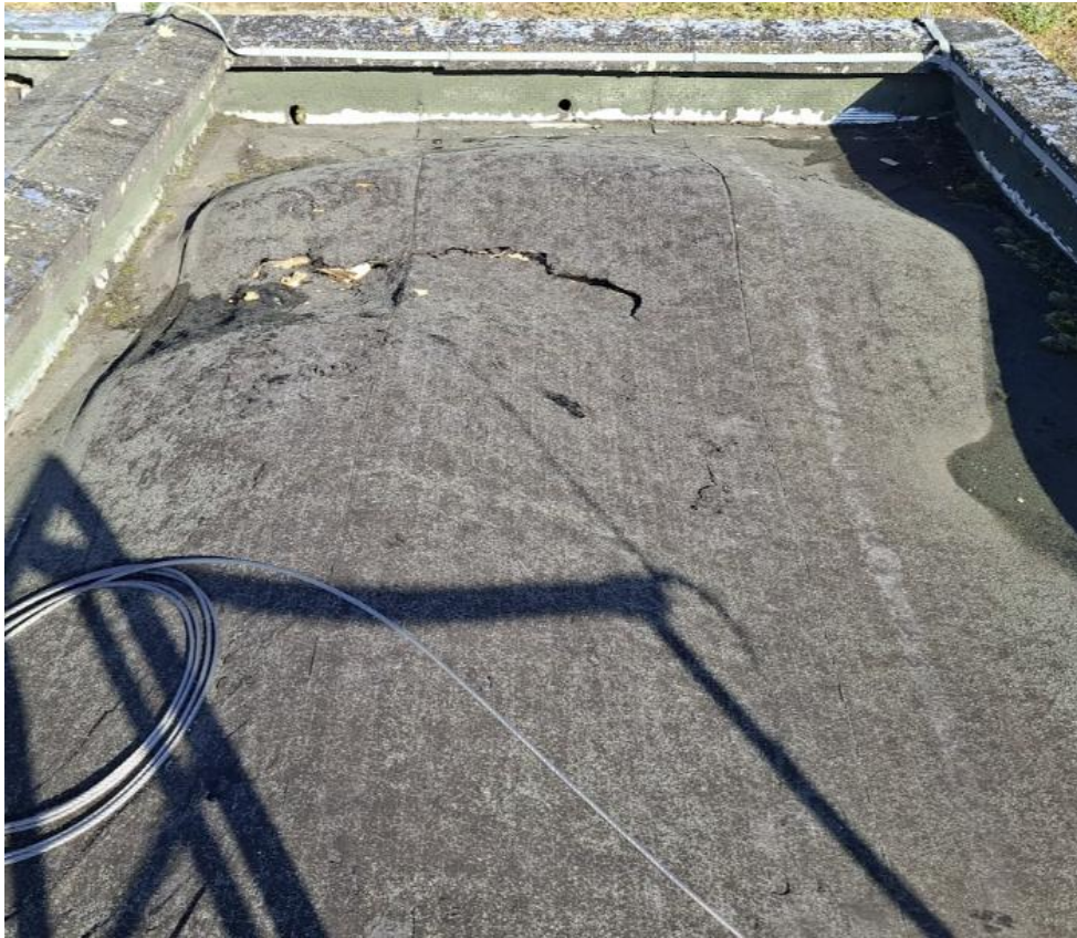
Etat général vieillissant / étanchéité faïencée / Impact de grêle
