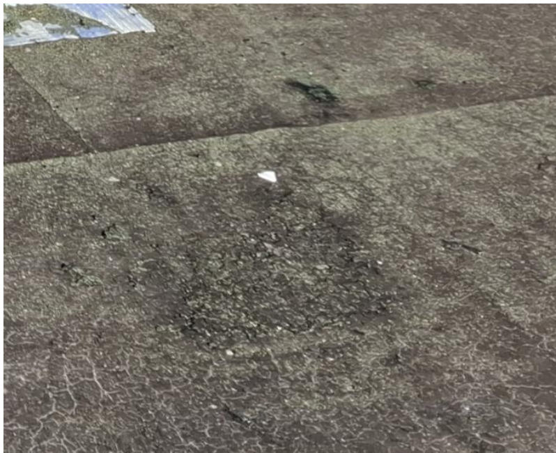
Etat général vieillissant / étanchéité faïencée / Impact de grêle
