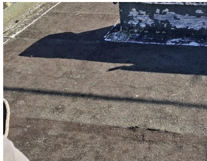
Etat général très vieillissant / étanchéité faïencée / Impact de grêle
