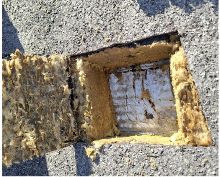
Le sondage R+ 3 met en évidence un complexe bicouche sur isolant de laine minérale. L'isolant est trempé et mesure 60 mm d'épaisseur
